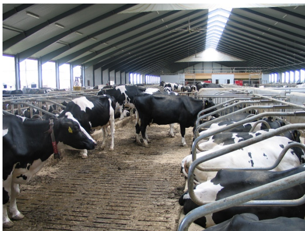
Figur 8.18. Foto af sengebåsestald med spaltegulv i gangarealerne. Under spaltegulvet er der en gyllekanal opbygget med enten ringkanalsystem eller med bagskyl. Sengebåsene er støbt i beton og er hævet i forhold til spaltegulvet og er udstyret med bøjler for adskillelse af kørerne, når de ligger. Bundene af sengebåsene dækkes med enten gummi-måtter og strøelse eller lignende (se øverst i afsnit 8.7) (Foto: SEGES).
