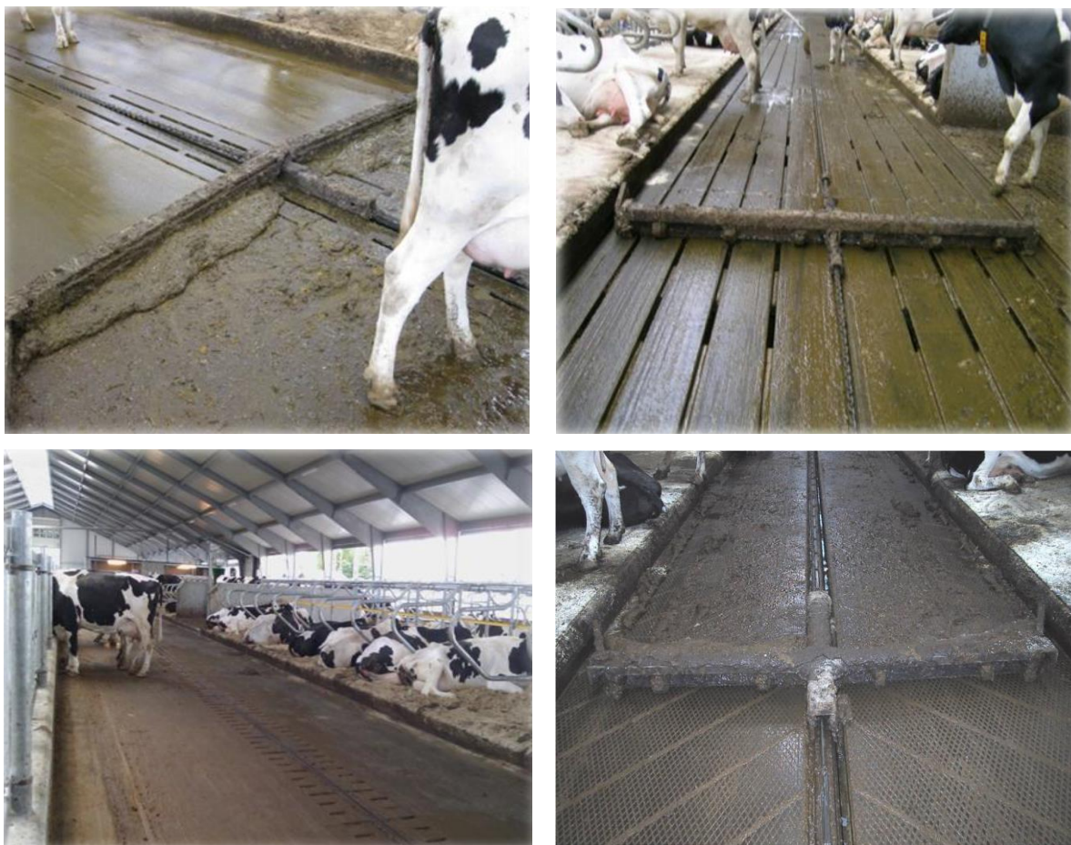
Figur 8.20. Eksempler på forskellige udformninger af fast drænet gulv i sengestalde. Der findes flere typer, som vurderes at være omfattet af definitionen (Anonym, 2012).
