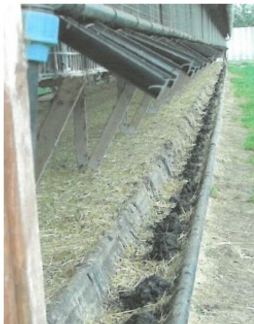
Figur 8.33. Tv.: Snittegning af minkhal med bure i to rækker og nedgravede gødningsrender (Kilde: Landbrugets byggeblade gr.nr. 110.5-02/1997). Th.: Foto af nedgravede gødningsrender (Kilde: M.H. Hansen, Brønderslev kommune). Viste anordninger for afledning af drikkevandsspild udenom gødningsrenderne er ikke lovpligtige.
