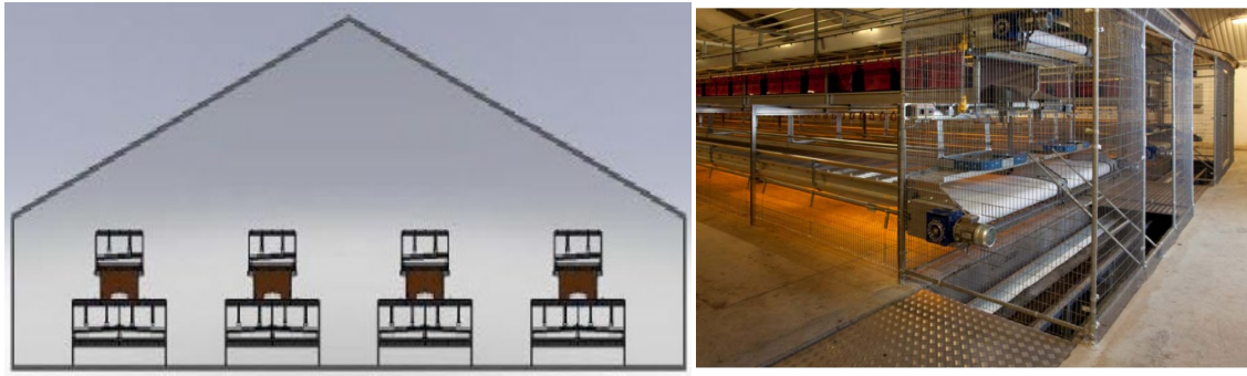
Figur 8.27. Tv.: Eksempel på konsumægsstald med gulvdrift og etagesystem med gødningsbånd. Th.: Foto visende etagesystem med gødningsbånd, som afleverer fjerkrægødningen for enden af systemet i en tværkanal, der transporterer gødningen ud af stalden (Kilde: SEGES).
