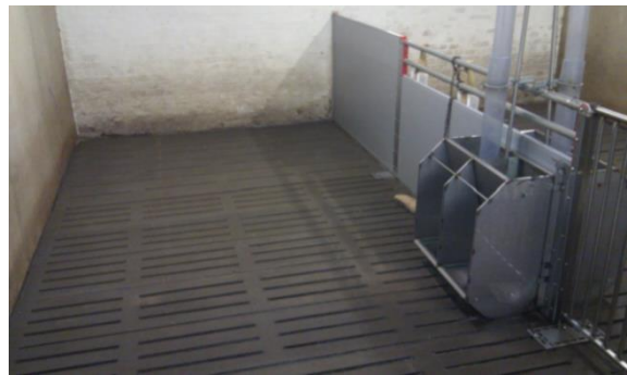
Figur 8.2. Eksempler på slagtesvinestier, der er omfattet af definitionen på drænet gulv og spaltegulv. Tv.: Skitse af slagtesvinestier med henholdsvis drænet gulv bagerst og midt i stien (Tegning: Peter Kai. Th.: Foto af sti med drænet gulv (bagerst) og spaltegulv (forrest) (Foto: SEGES)).
