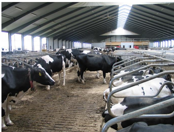
Figur 8.18. Foto af sengebåsestald med spaltegulv i gangarealerne. Under spaltegulvet er der en gyllekanal opbygget med enten ringkanalsystem eller med bagskyl. Sengebåsene er støbt i beton og er hævet i forhold til spaltegulvet og er udstyret med bøjler for adskillelse af køerne, når de ligger. Bunden af sengebåsene dækkes med enten gummimåtter og strøelse eller lignende (se øverst i afsnit 8.7) (Foto: SEGES).
