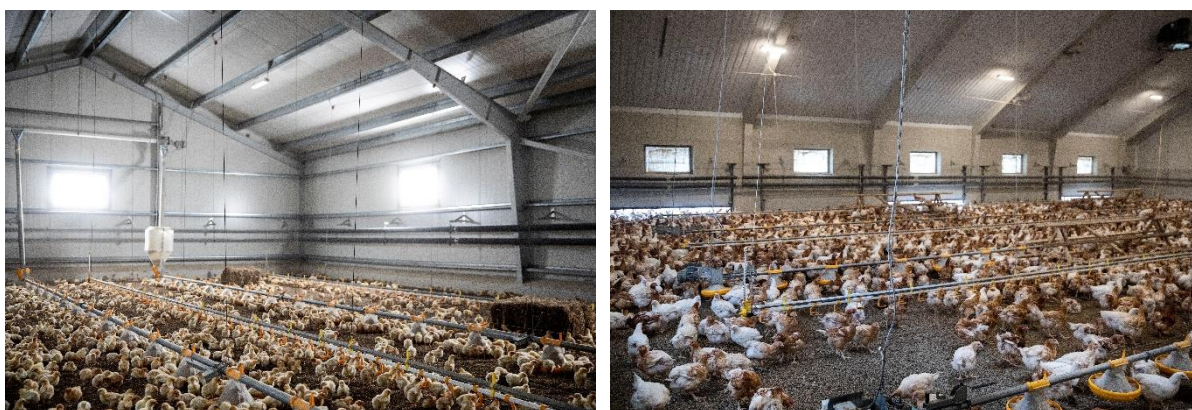
Figur 8.23. Fotos af økologiske slagtekyllingestalde. Tv.: Starterstald med gulvsystem. Th.: Voksestald med åbning langs facaden for adgang til udeareal (Foto: SEGES).
